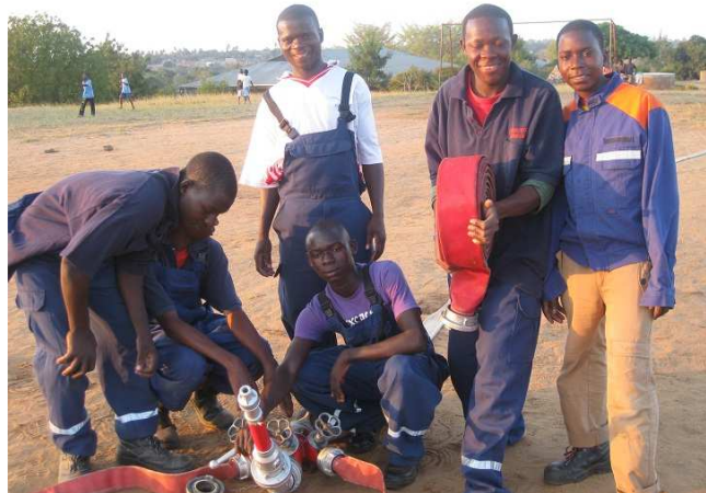
Bau eines Wasserwerfers
